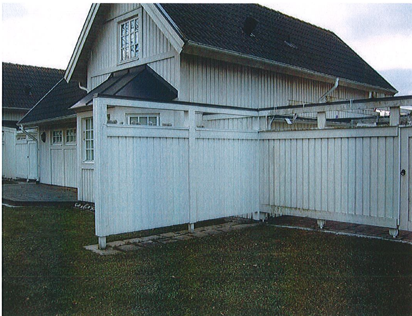
B.5-2, Skärmvägg vid utökad terrass ( hus 198 )
