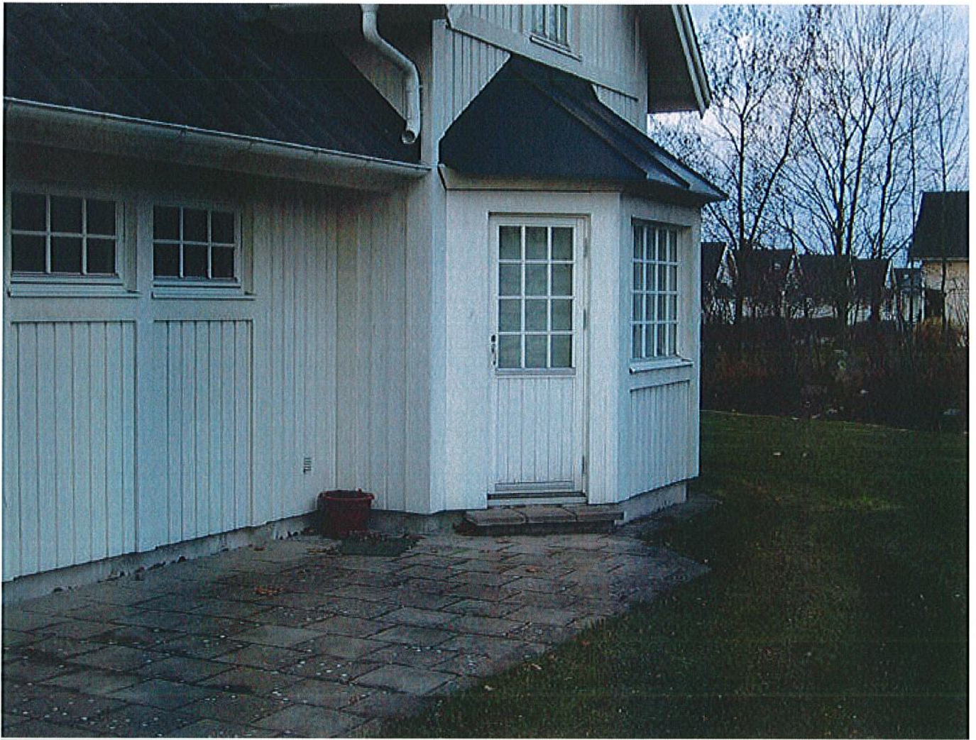
B.5-1, Fönsterdörr ( hus 198 )
