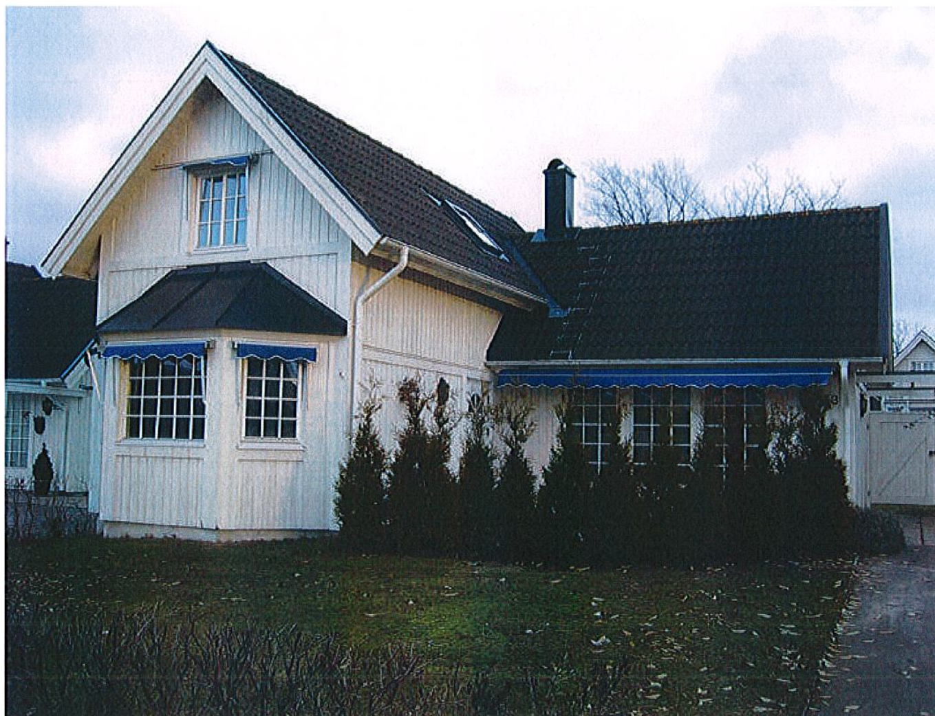
B.8. Markiser ( hus 153 ) (markiser även på andra sidan huset)
